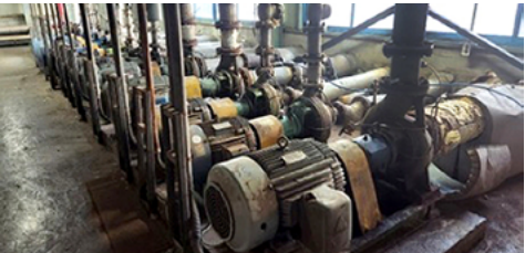
용수쿨링펌프 인버터 설치(세아씨엠)
