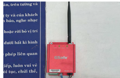
화재경보 송신 시스템(SeAH Steel Vina)
