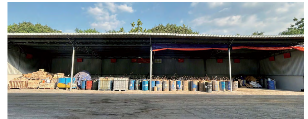
Bien Hoa 공장 신축(SeAH Steel Vina)
