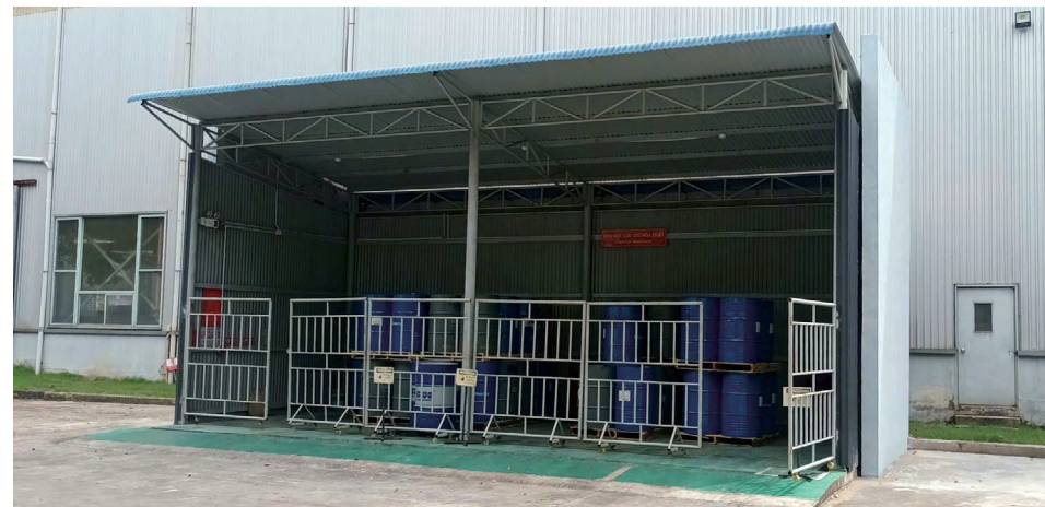
화학창고 개보수 및 신축(SeAH Steel Vina)
