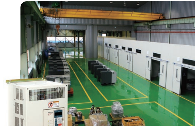
Inverter[좌] 앤틀공장 내부[상]
