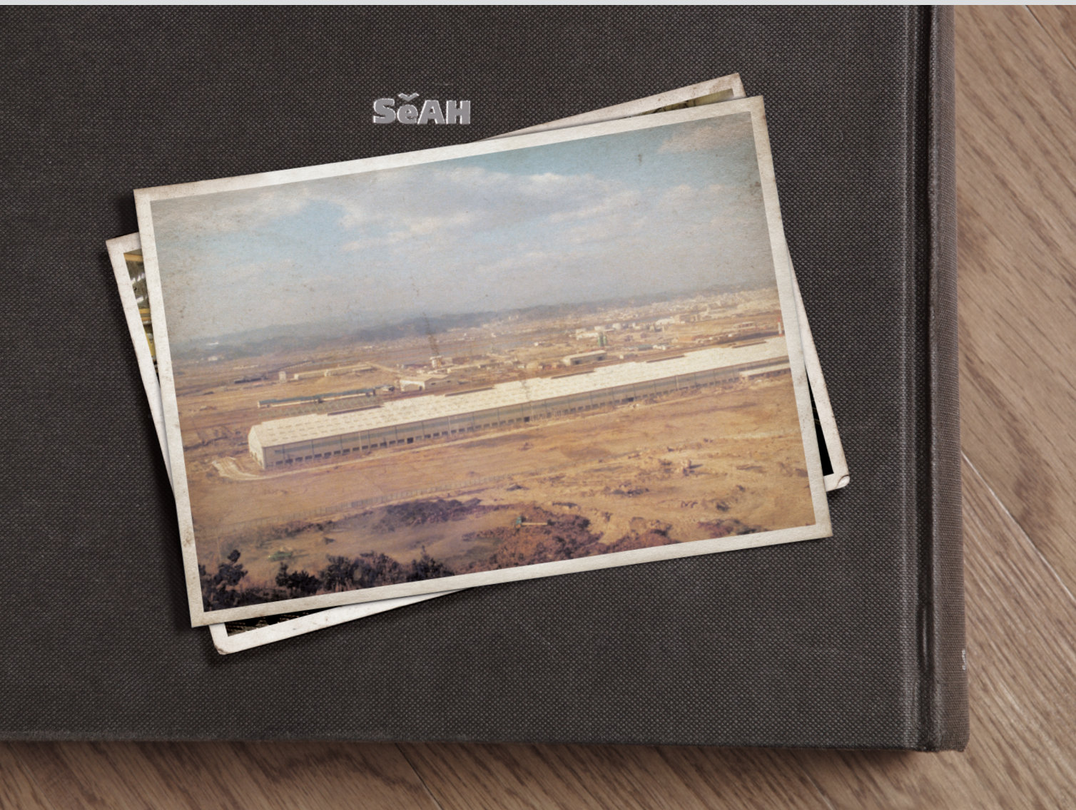
포항 제1공장 건설 현장(1977년)
