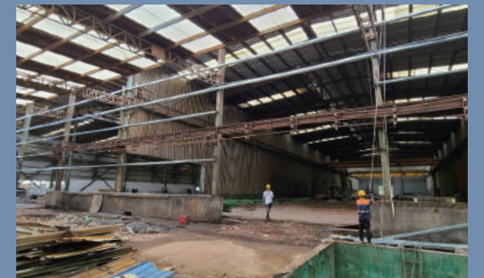
공장을 건설 중인 모습
