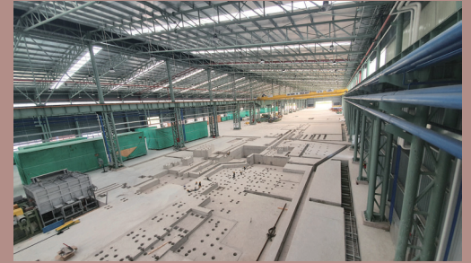
공장동 내부 전경
